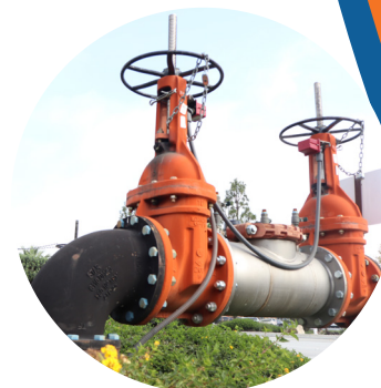
Conjunto de prevención de retroflujo de doble válvula de retención
