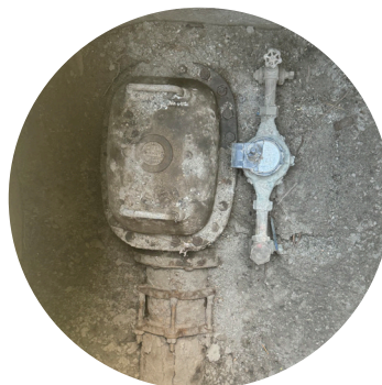
Conjunto de prevención de retroflujo de una sola válvula de retención
